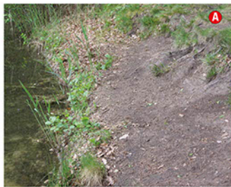
Man erkennt deutlich die ehemalige Uferkante
